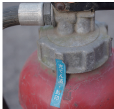
× キャップの劣化
