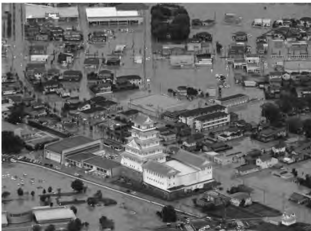
平成27年9月関東・東北豪雨災害（豊田城・地域交流センター）
